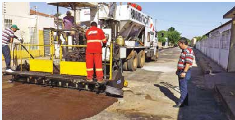
Muitas obras de infraestrutura estão sendo desenvolvidas pela gestão Ubiratan Jucá
