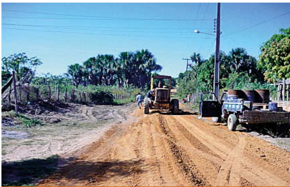
Recuperação de estradas vicinais interligando povoados a sede do município
