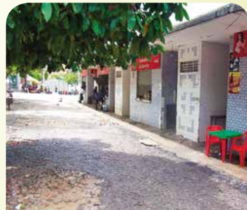
O Abrigo do Largo do Carmo só abriga sujeira e marginalidade
